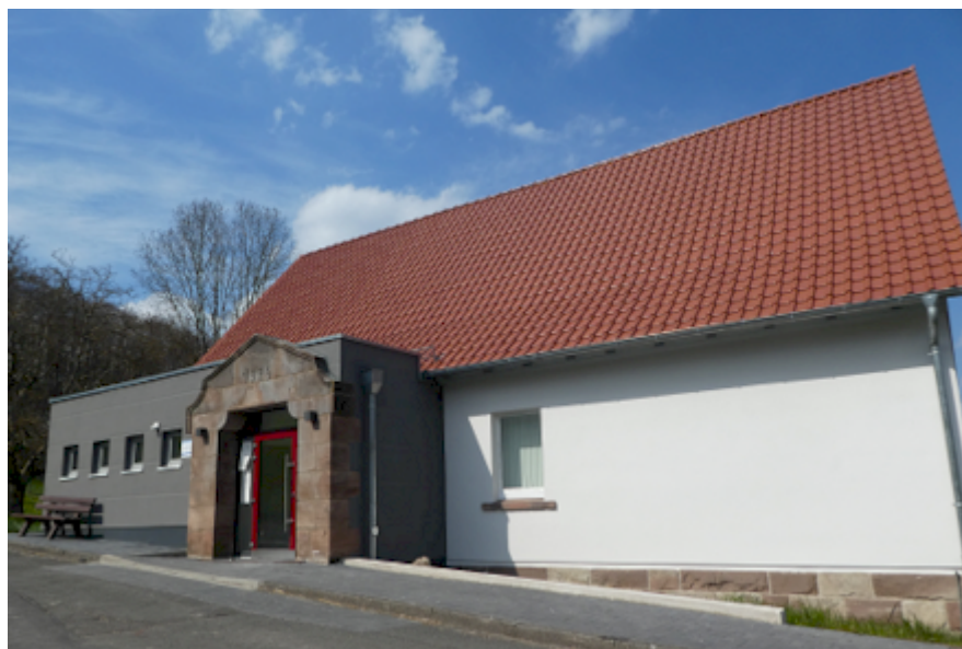
Dorfgemeinschaftshaus Weißenbach nach der Sanierung
