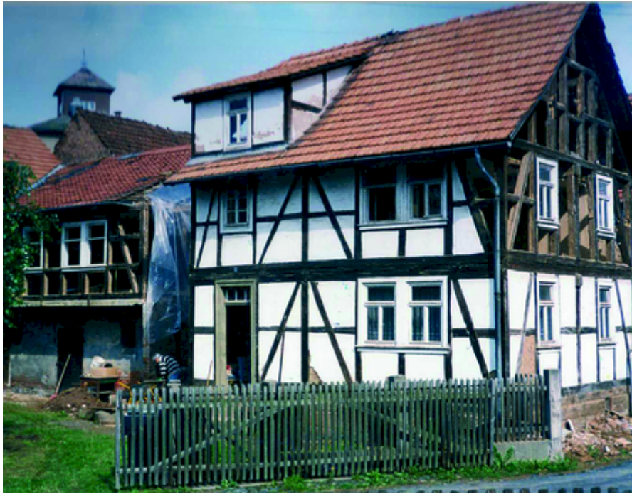
Fachwerkhaus vor der Sanierung
