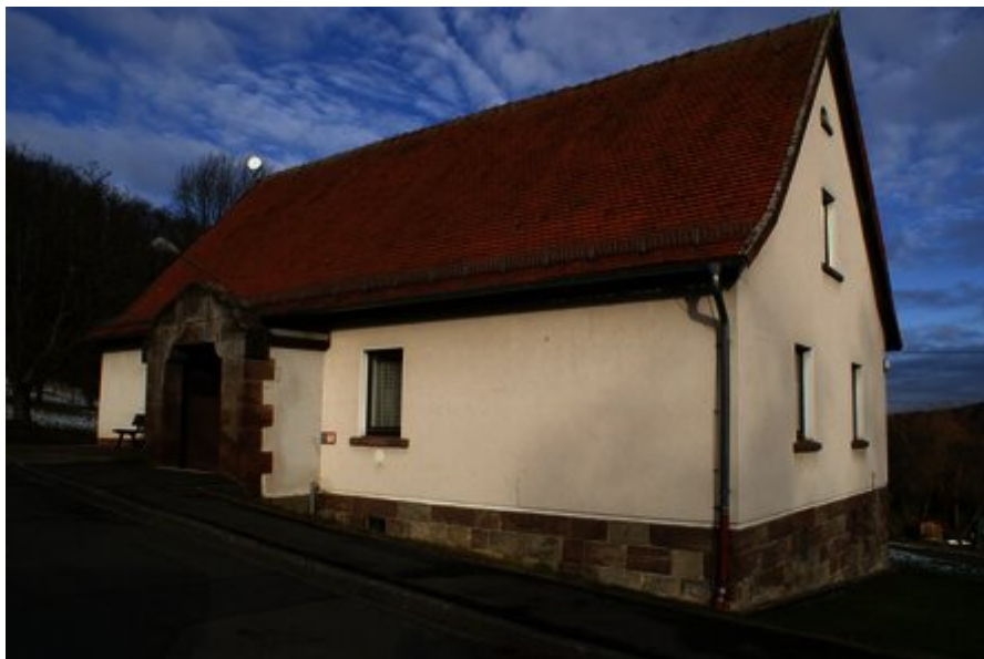
Dorfgemeinschaftshaus Weißenbach vor der Sanierung
